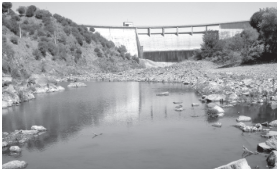
Figura 12. Presa de Gérgal (Sevilla). Fotografía: Julio Miguel Luzón-Ortega.
